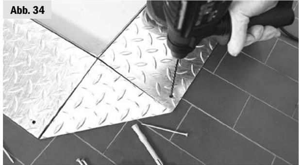
**6.** Készítse elő a rámpák/rögzítő konzolok csavarozását. A rögzítő konzolokhoz 2 laposfejű (ca.M8) csavar szükséges. A csavar és a tipli hossza és fajtája az aljzattól, padozattól függ.
