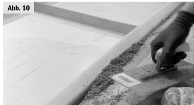
8. Tömören öntse ki a tálcák és a kirekesztés széle közötti rést. Hagyjon helyet a poliuretán fugának. Hagyja a tömitést, ragasztót megszáradni.
