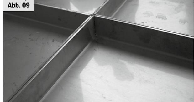
7. A tálcákat ütközésig tolja egymáshoz és azok magasságának eltérése +/- 0,5 mm lehet. Adott esetben a tálcákat alulról is egymáshoz rögzíthetik.
