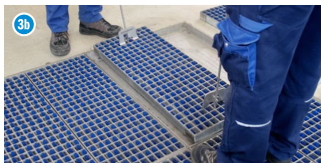
A rostély visszahelyezése emelőkampókkal. Re-insert the grates with lifting hooks. Izgaraları kaldırma kancalarıyla tekrar yerleştirin. Réinsérez les grilles dans les bacs à l'aide des 2 longs crochets. Vuelva a insertar las rejillas con ganchos de elevación. Reinserire le griglie con ganci di sollevamento.
